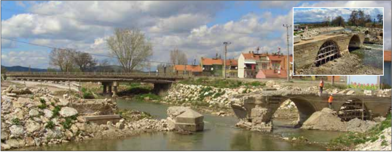
Ada Köprüsünde yapılan restorasyon çalışmaları
